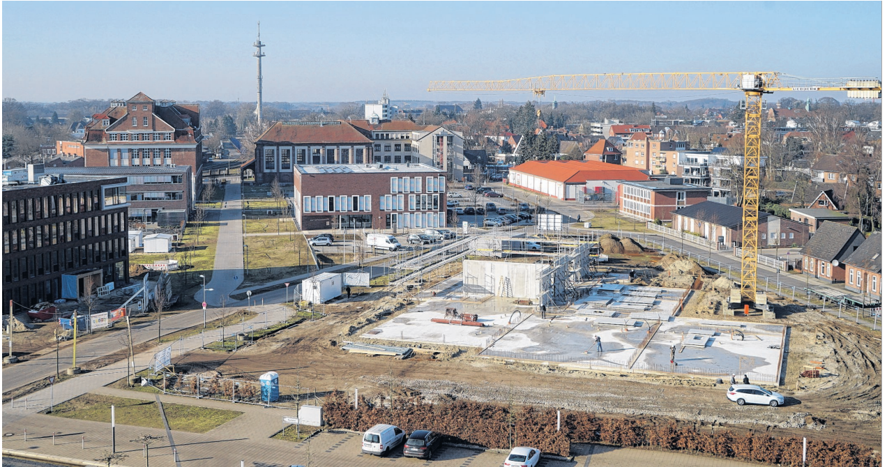
Erste Betonwände für den Kinoneubau auf dem NINO-Gelände sind aufgestellt. Grundrisse der entstehenden sechs Säle sind schon erkennbar. Foto: Westdörp
