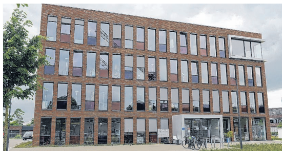
Das Haus an der Nino-Allee 4 hat vor einem Monat bereits den Betrieb aufgenommen.
