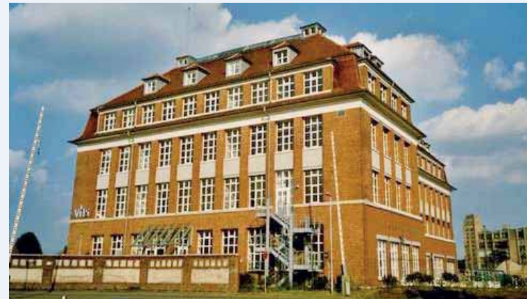
Volkshochschule im ehemaligen Rohgewebelager
