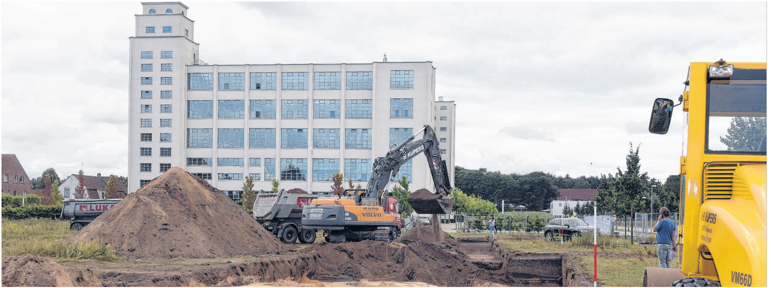
Mit ersten Erdarbeiten hat auf dem NINO-Gelände der Bau des Kinozentrums begonnen. Investor und Betreiber hatten bereits im Frühjahr angekündigt, das Multiplexzentrum bis Mitte 2017 fertigstellen zu wollen. Foto: Konjer
